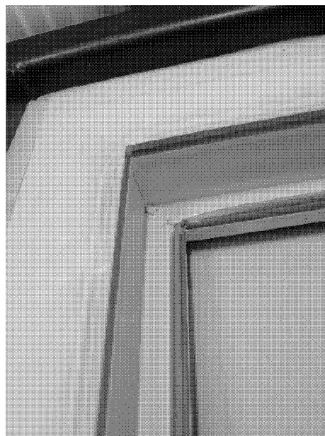
Foto 4 Detail Rahmeneckverbindung oben
